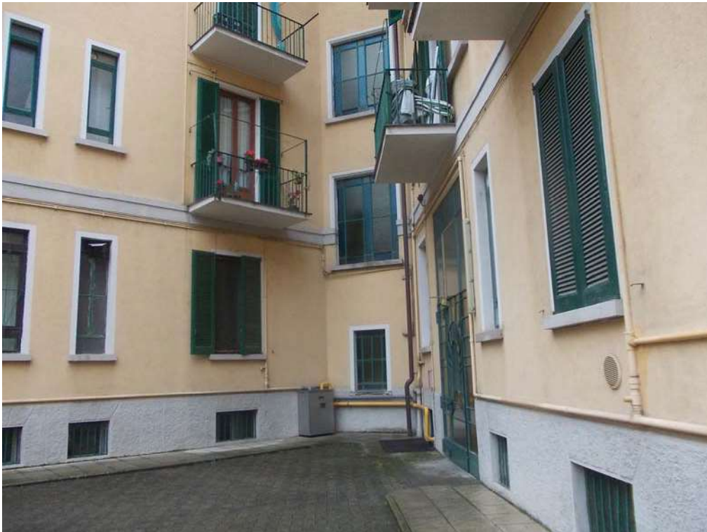
Vista interno fabbricato ed area comune condominiale
