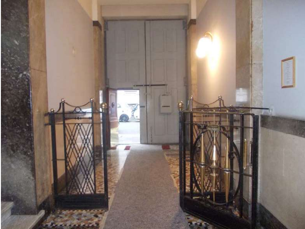
Androne: vista dall'interno
